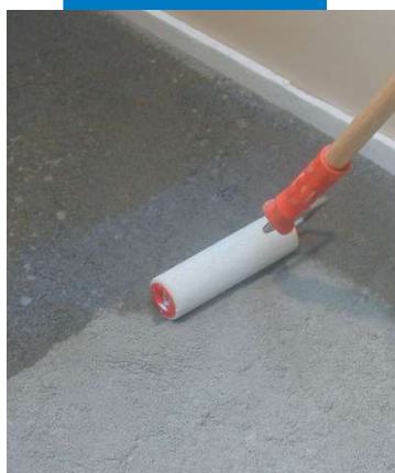
Thi công Primer G bằng rulo lăn
